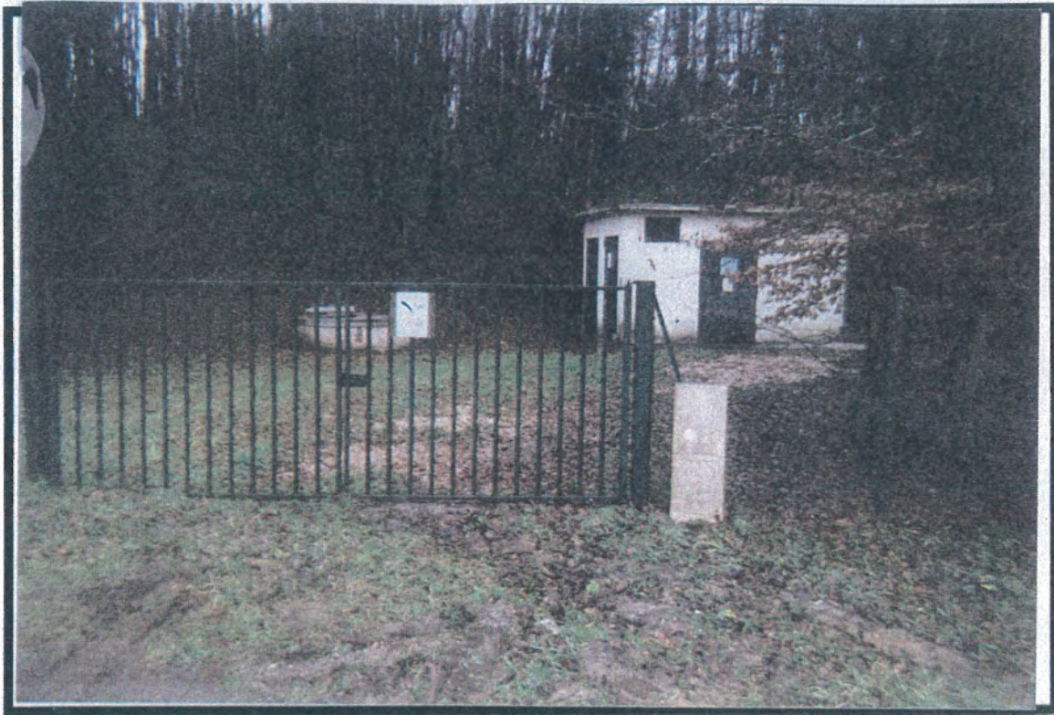
PHOTO P1 : Portail et périmètre immédiat
